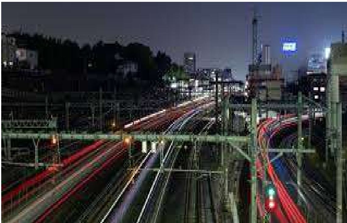
L'approche des grandes gares et la nécessité d'une parfaite régulation pour assurer la fluidité du trafic
