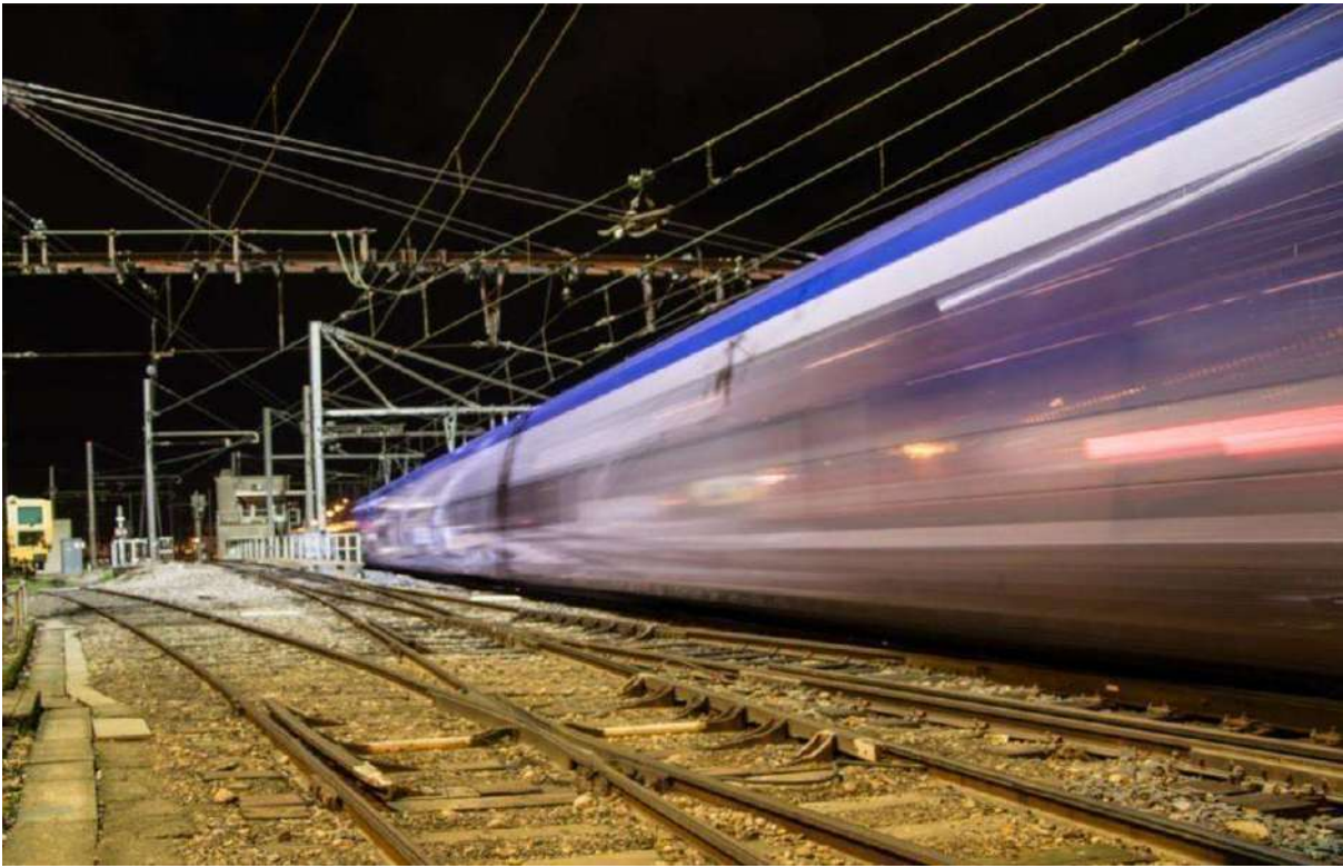
La nécessité d'une infrastructure très bien entretenue pour assurer régularité et rapidité des trains
